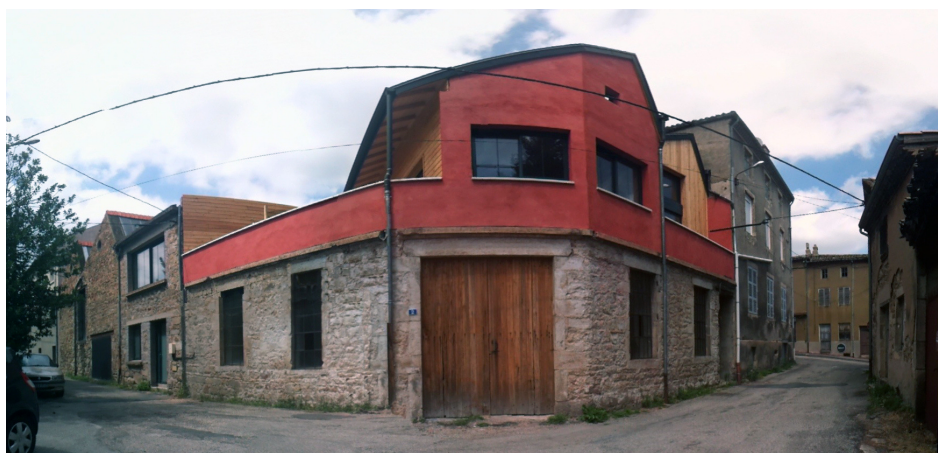
3. Vue est du bâtiment après-travaux
