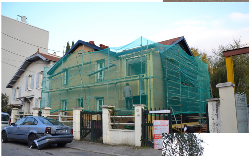
7. Pose du pare-pluie sur les façades recevant un bardage bois. Source : Yann Damiani a. Vue nord
