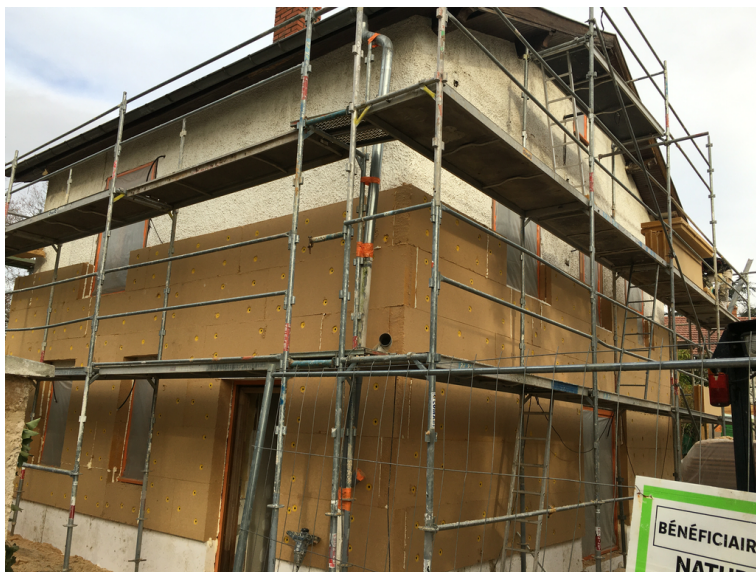
5. Pose des panneaux de fibre de bois
