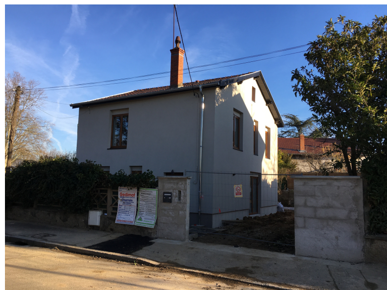
2. Vue sud des travaux finis.
