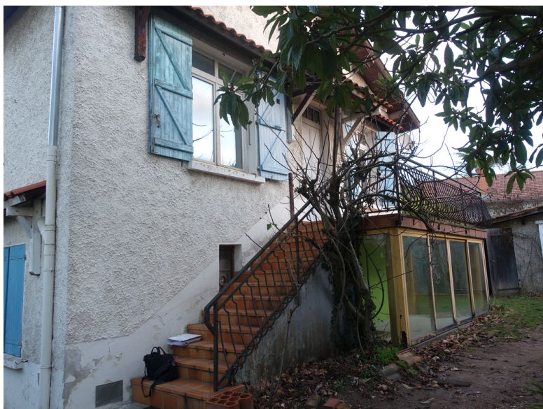
4. Façade sud-est avant les travaux
