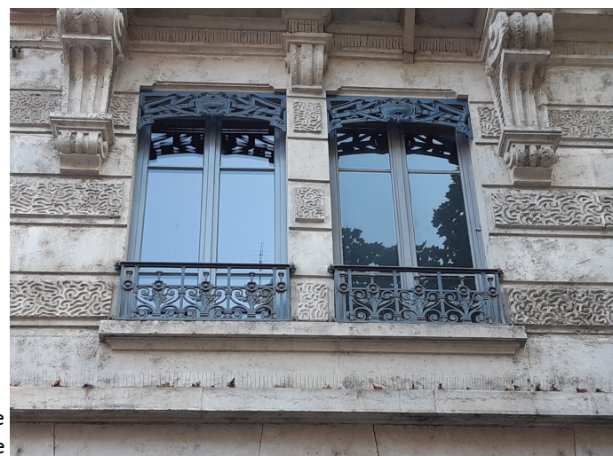
3. Façade nord. A gauche : fenêtre neuve A droite : fenêtre ancienne
