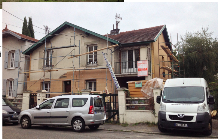
6. Pose de la laine de bois. Source : Yann Damiani
