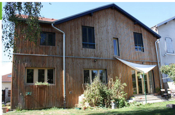
3. Façade sud-est. Source : Yann Damiani
