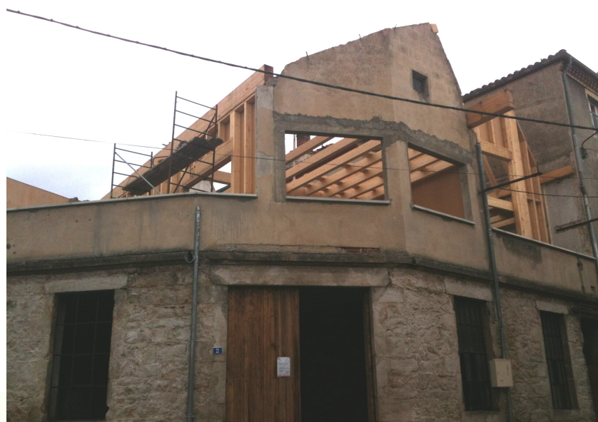
6. Mise en place de l'ossature bois porteuse
