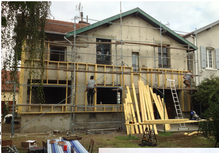
5. Pose de l'ossature bois. Source : Yann Damiani
