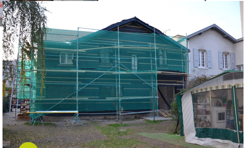
b. Façade sud-est
