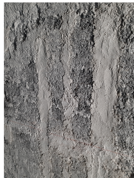
8. Comblement des saignées existante par un mortier chaux/chanvre/argile expansé
