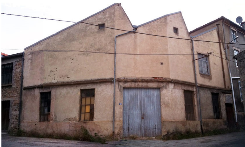
5. Vue est du bâtiment avant travaux
