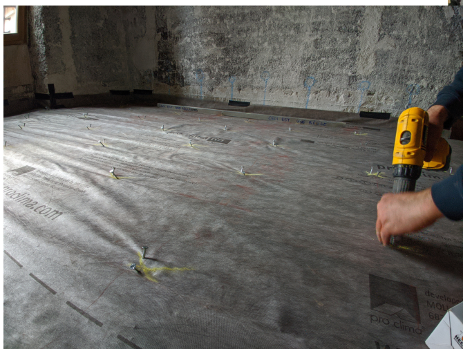
9. Pose de vis croisées qui liasonneront la chape ciment et le parquet existant
