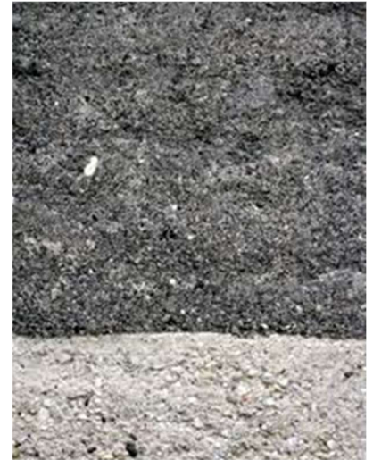
Figure 4. Mur en béton de mâchefer sur un soubassement en béton "classique". Source : [14]
