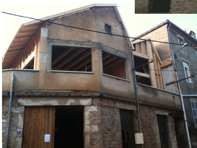
7. Pose de la nouvelle toiture à shed
